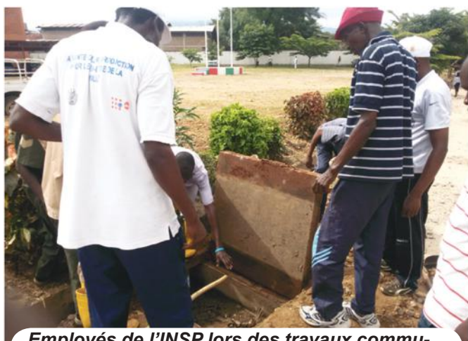
Employés de l'INSP lors des travaux communautaires de débouchage de caniveaux
